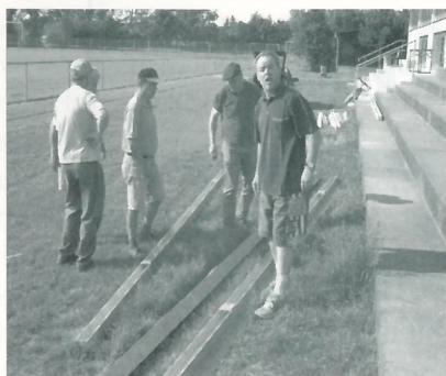
Auch beim Bau der Terrasse voll dabei
