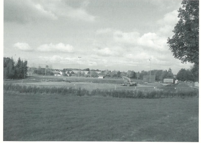
Der neue Rasensportplatz im Bau ..Stand Oktober 2002
