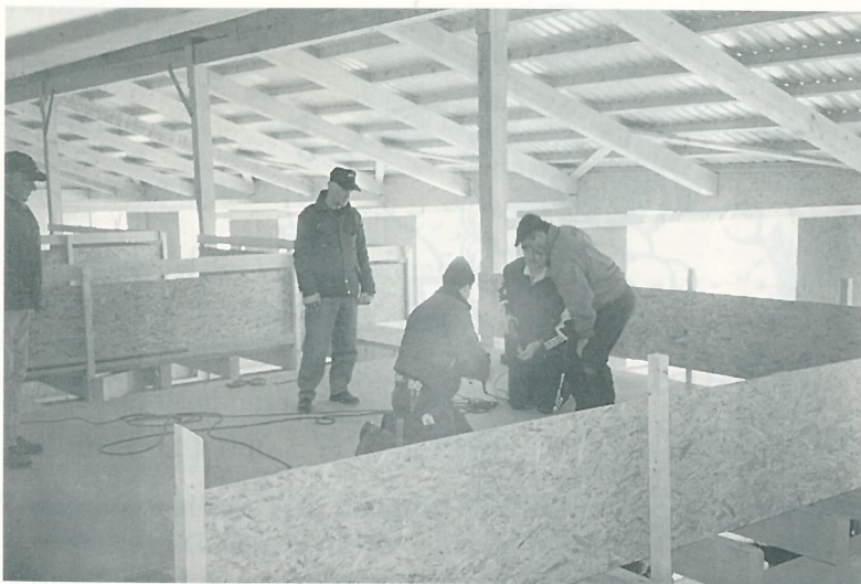
Ausbau des Lagerschuppens an der Bahnhofstrasse (Einweihung 06.05.2001)
