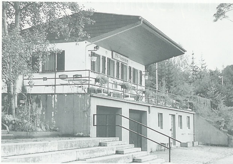
Unser altes Vereinsheim, gebaut 1952/1953
